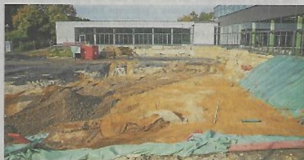
Die nächste Baustelle: Im kommenden Jahr soll der Außenbereich mit mehreren Becken eröffnet werden.
