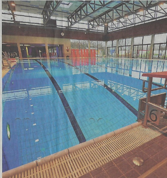
Der Umbau des Dinamare ist mittlerweile abgeschlossen, doch aufgrund der steigenden Inzidenz in den vergangenen Wochen hat das Schwimmbad weiterhin zu.
