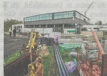
Die Liegewiese ist auch im nächsten Sommer noch Baustelle. FOTO: LF / FFS
