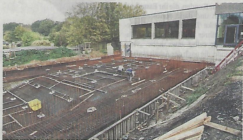
Die Form des künftigen Sportbeckens ist bereits zu erahnen. Es soll durch zwei Zugänge erreichbar sein.
