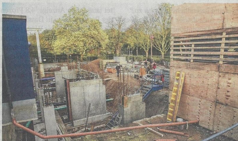
Hier entsteht der erweiterte Umkleidetrakt.
