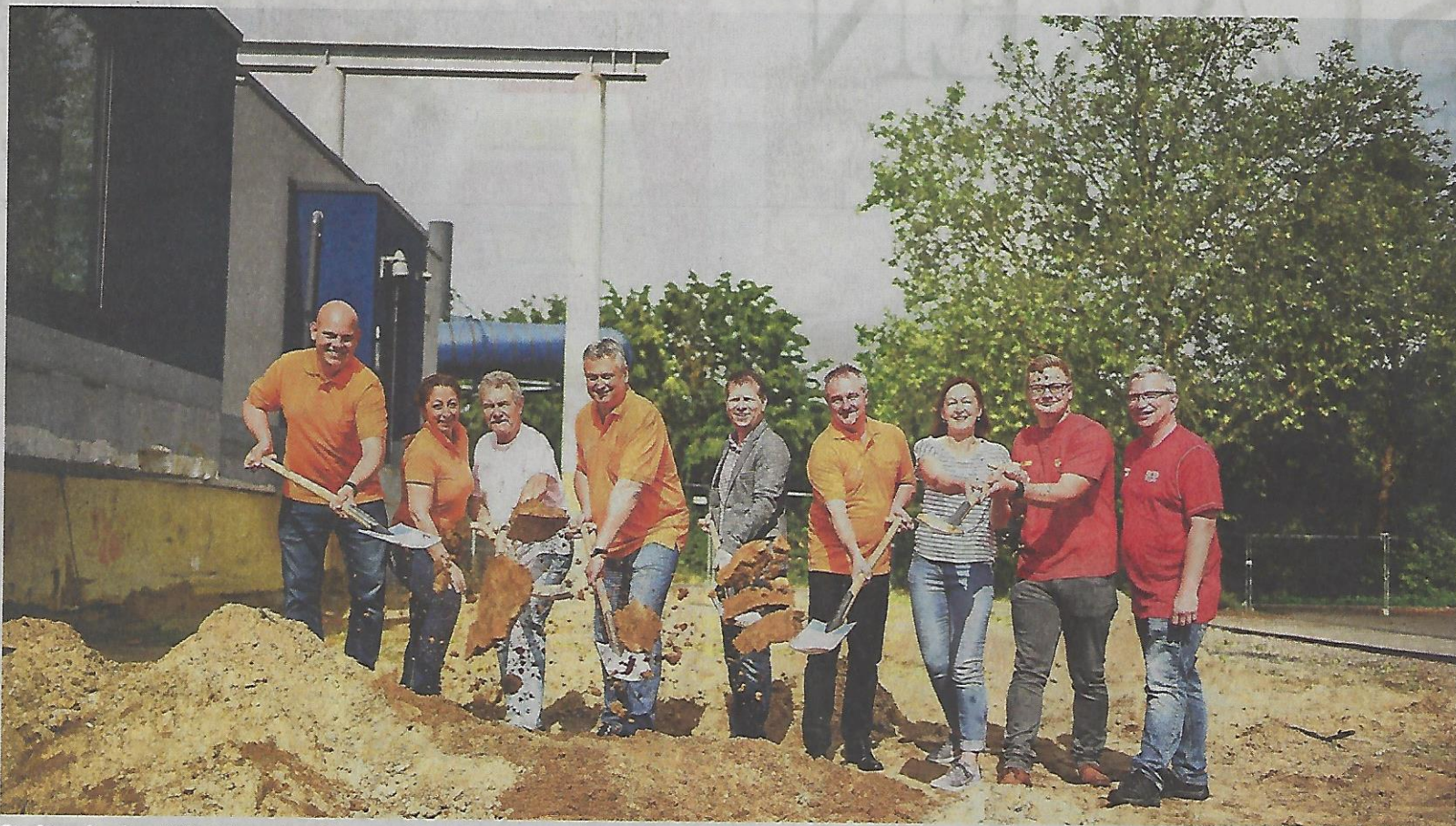
Stadtwerke-Geschäftsführer Josef Kremer (4.v.li.), Architekt Jochen Batz (5.v.li.) und Vertreter der Sportvereine am Freitag beim Spatenstich zur Erweiterung des Dinamare.
