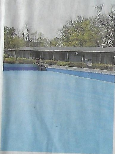
Das Freibad Hiesfeld nach der Leerung des Beckens.
