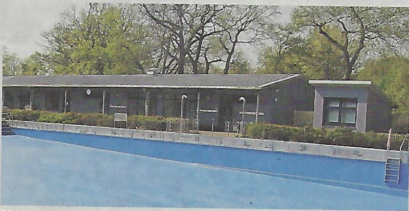
Die Sanierung des vorhandenen Beckens könnte für den Freibadvereine eine Lösung sein.
