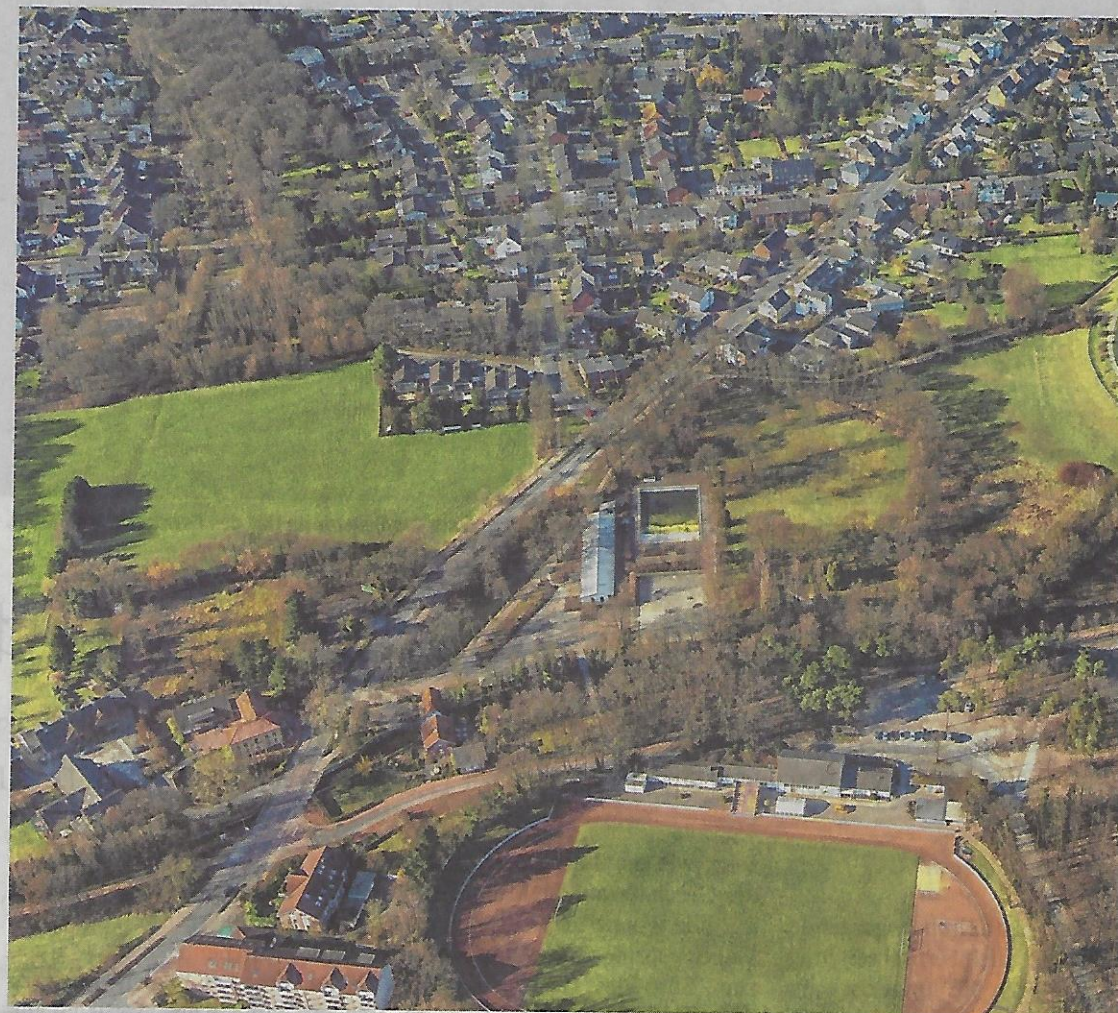
Die Entwässerung der Freibad-Baugrube könnte Schäden an Häusern im Umfeld von 200 Metern verursachen, so Gutachter. Auch das Mühlenmuseum, Haus Hiesfeld und Wohnhäuser könnten betroffen sein.
