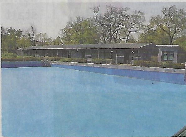
Das Freibad Hiesfeld nach der Leerung des Beckens.
