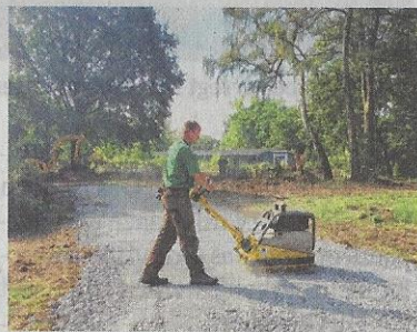
Die Arbeiten auf dem Freibadgelände haben im Sommer begonnen. FOTO: AHA
