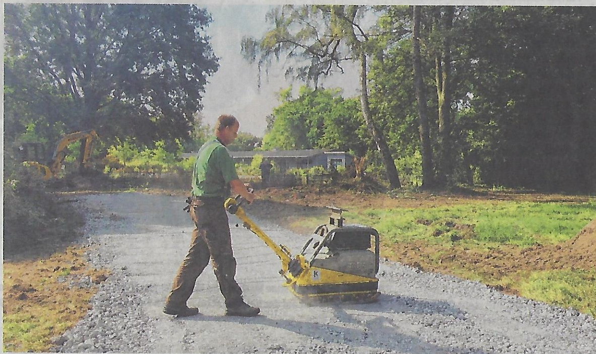
Im Freibad Hiesfeld wird seit Montag gearbeitet. Mit Baggern wurde Buschwerk entfernt, derzeit wird die Baustraße eingerichtet. Am 10. September muss das Gelände für den Kampfmittelräumdienst präpariert sein.
